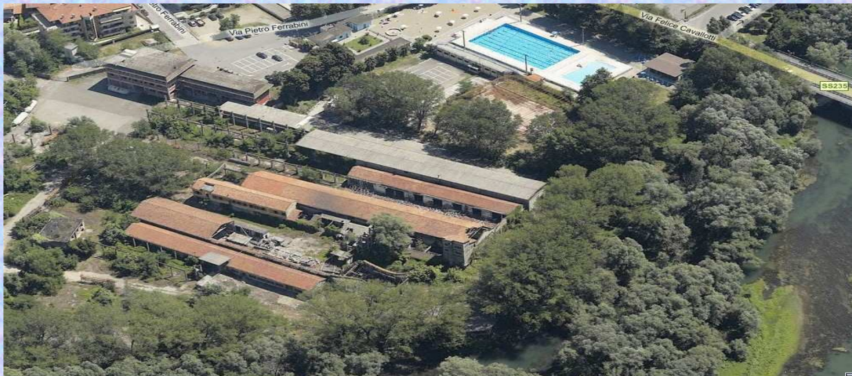
L'area ex SICC prima dell'intervento
