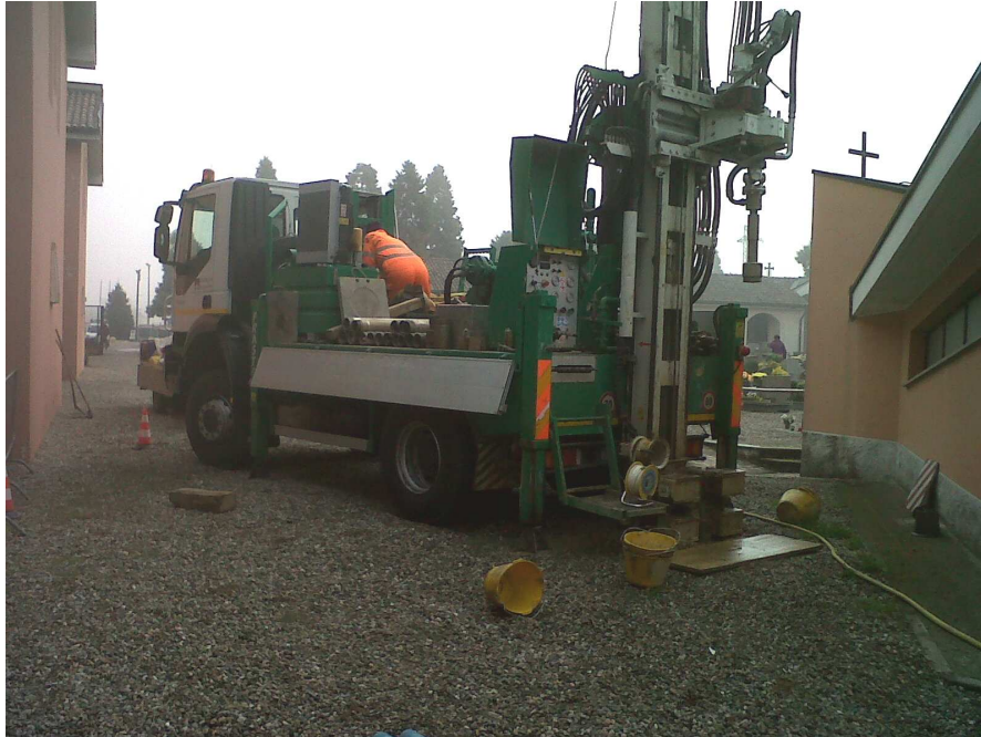
Perforazione del sondaggio successivamente allestito a piezometro
