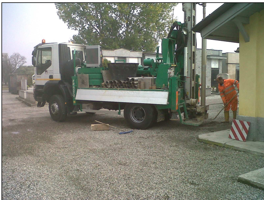
Perforazione del sondaggio successivamente allestito a piezometro
