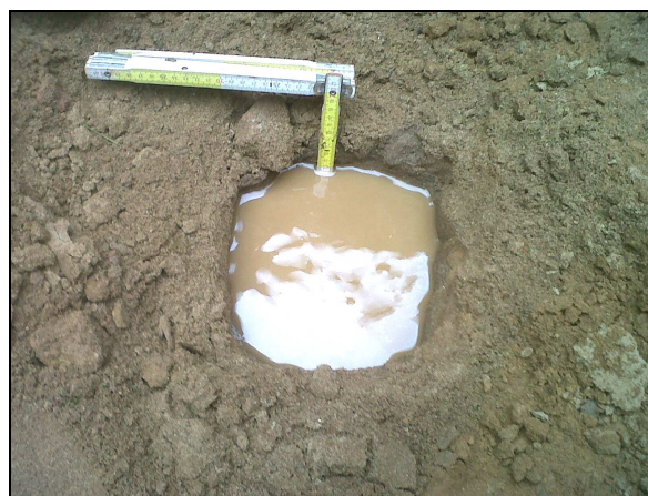
Prova di permeabilità
