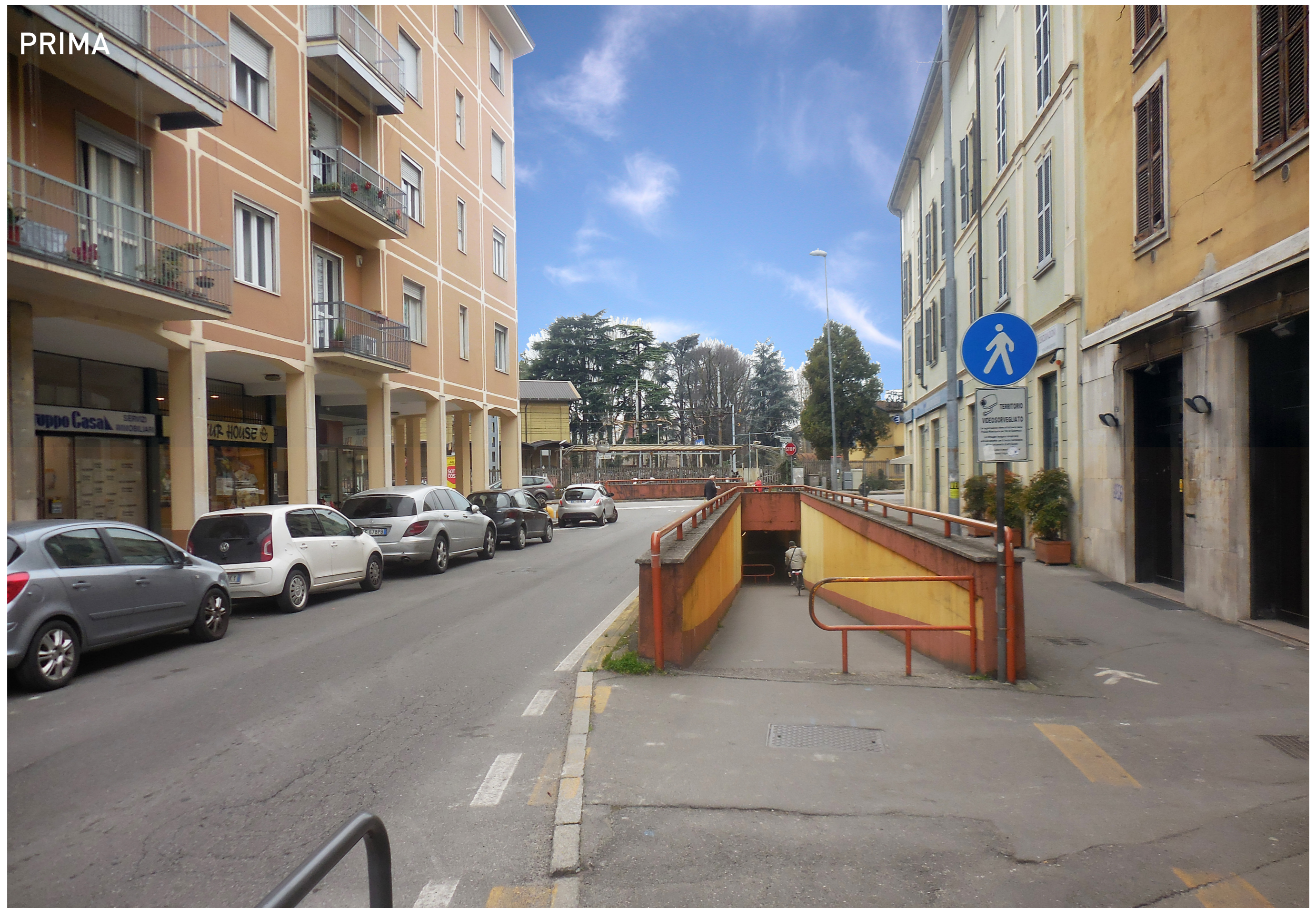
Città di Lodi | Sottopasso ferroviario di collegamento tra via Pavia e vie dall'Oro e Trento e Trieste
