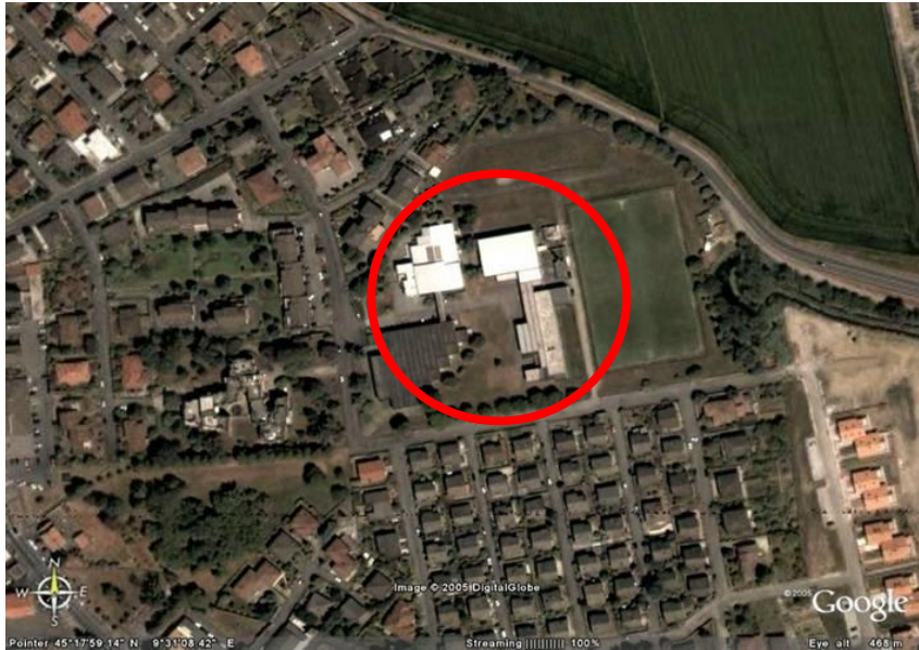
Fotografia aerea dell'area
