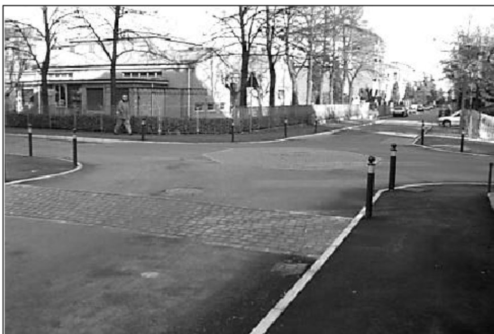
Interventi di ristrutturazione di crocevia in "zona 30" a Modena
