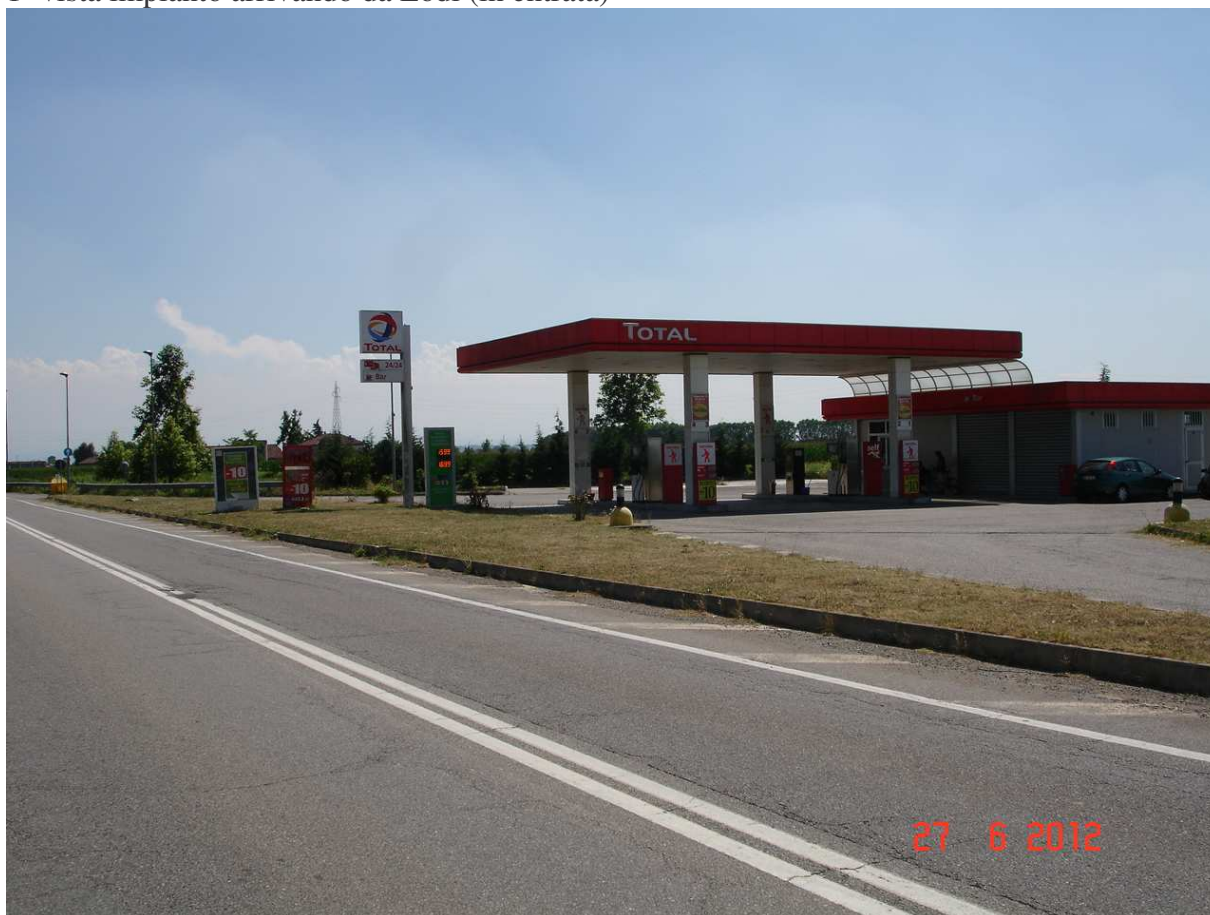
1- vista impianto arrivando da Lodi (in entrata)
