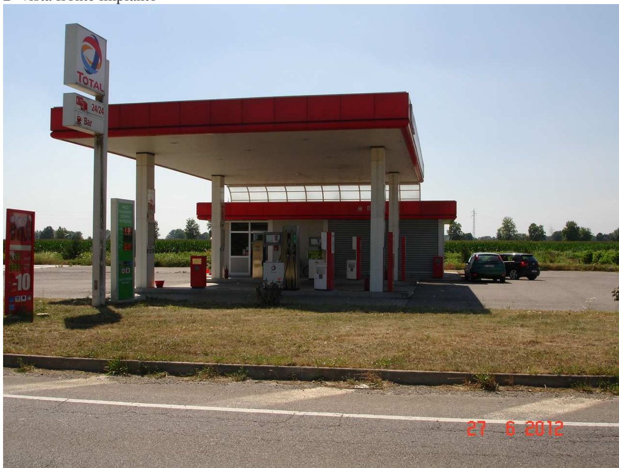
2- vista fronte impianto
