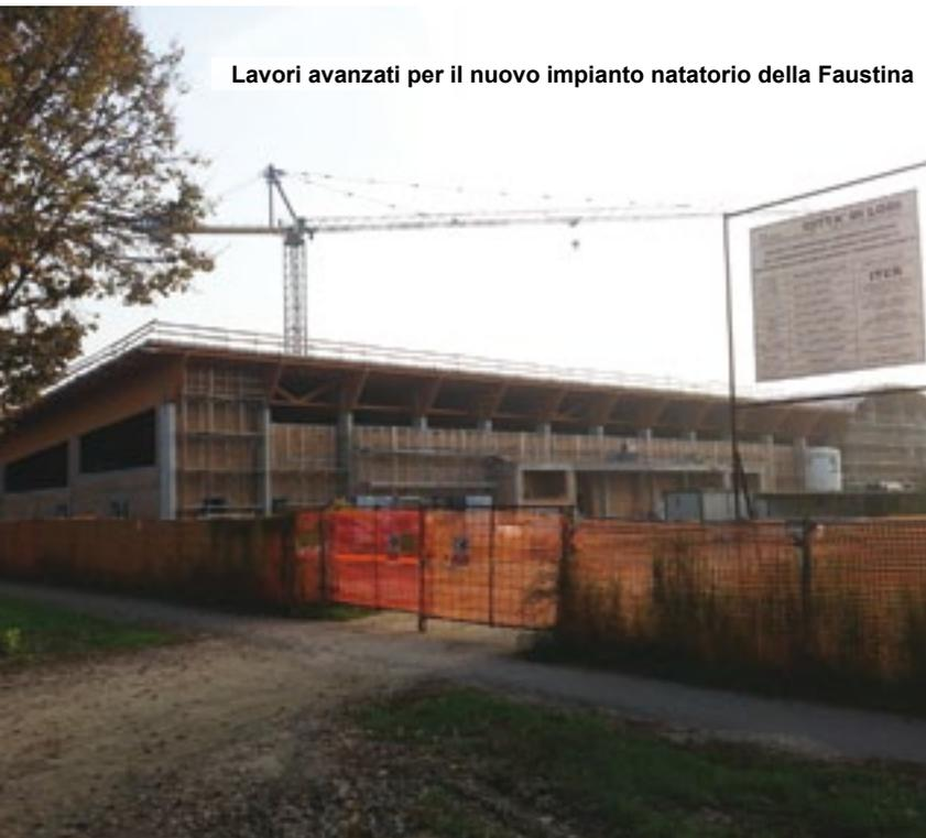
Dopo la posa dei serramenti, l'installazione di circa un terzo della parte impiantistica complessiva dell'edificio e l'inizio dei lavori di intonacatura, a fine ottobre il Comune e l'impresa costruttrice, l'Iter di Ravenna, hanno verificato congiuntamente il cronoprogramma delle operazioni stabilendo così le fasi finali della corposa operazione.
