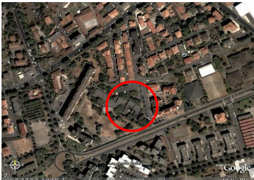
Fotografia aerea dell'area
