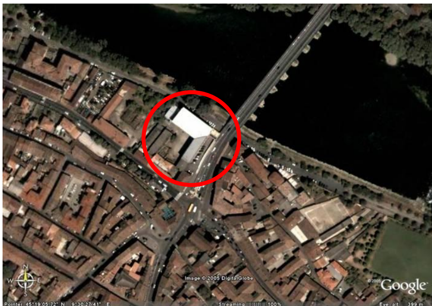
Fotografia aerea dell'area
