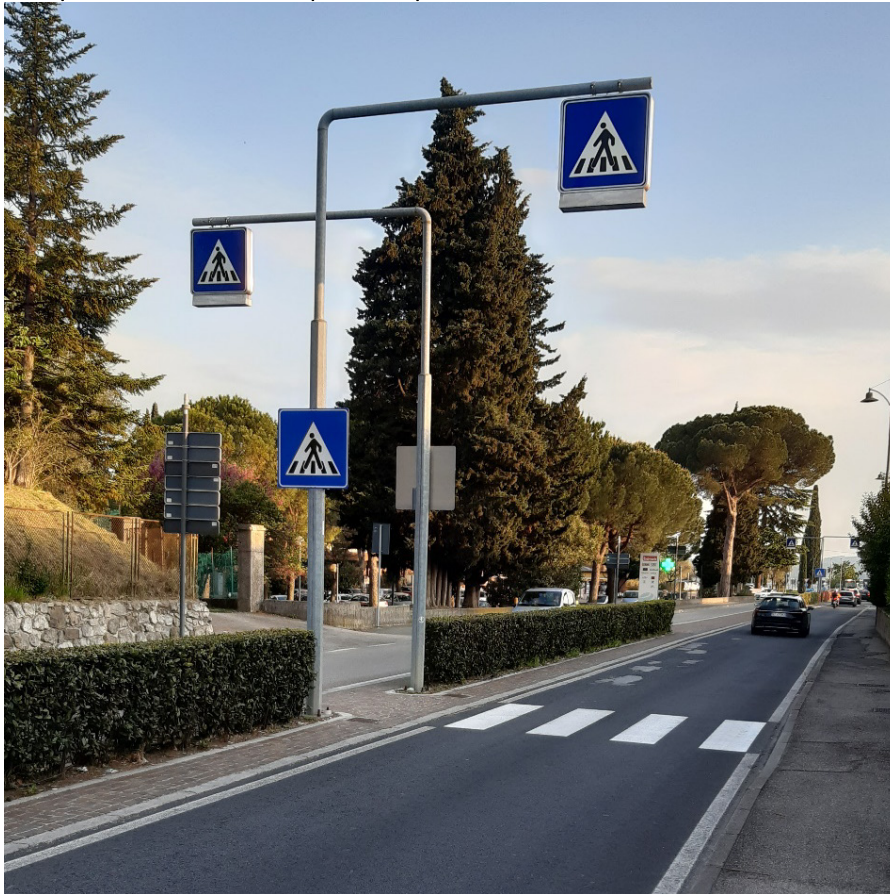
Esempio di attraversamento pedonale protetto
