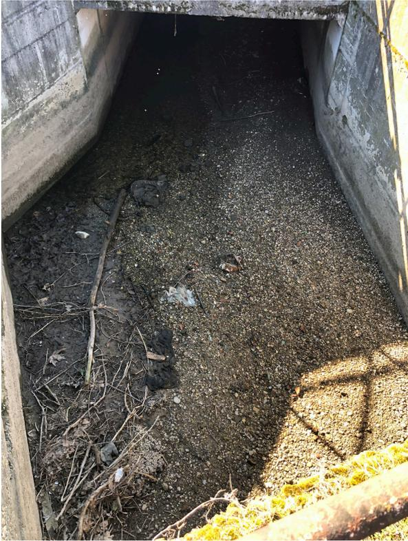
1E - Sottopasso di roggia Squintana al di sotto della rotatoria ad est di C.na Spolverera. Sono evidenti i detriti e la sedimentazione incontrollata che ostacola il deflusso idrico. Manutenzione assente.
