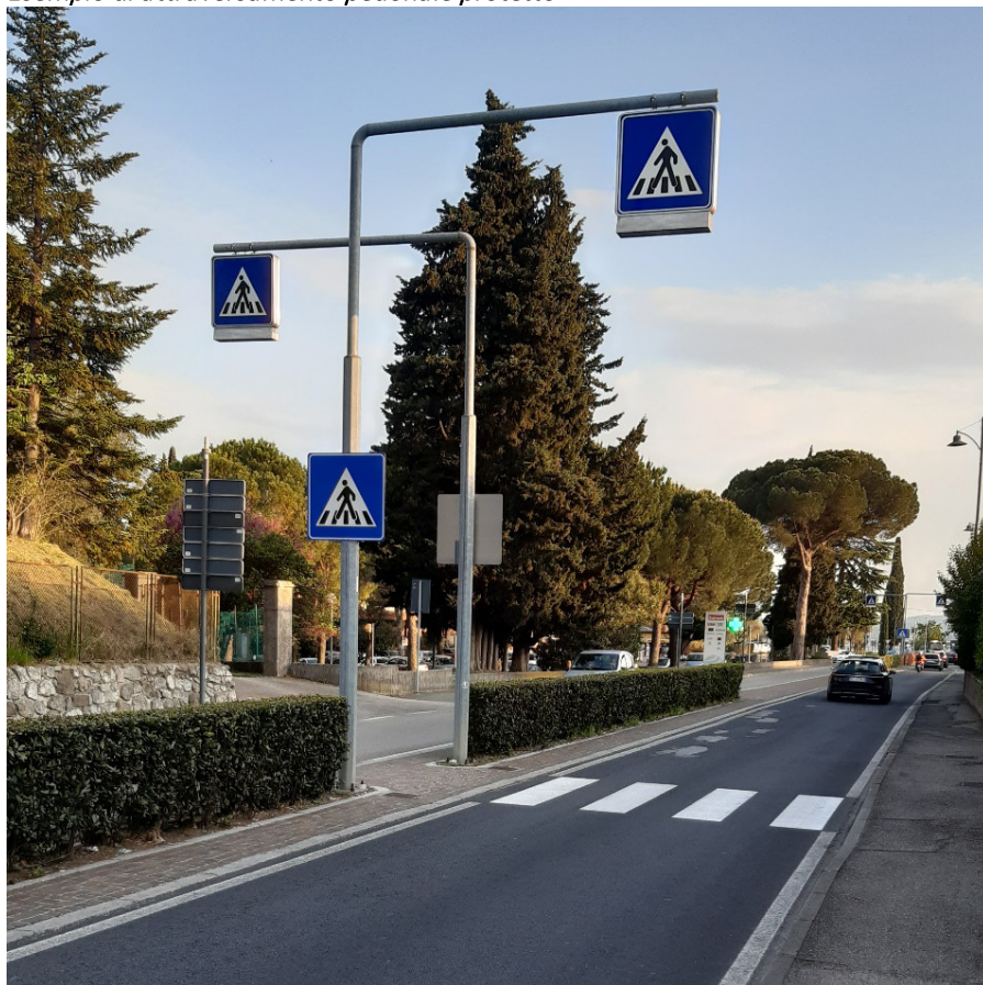
Esempio di attraversamento pedonale protetto
