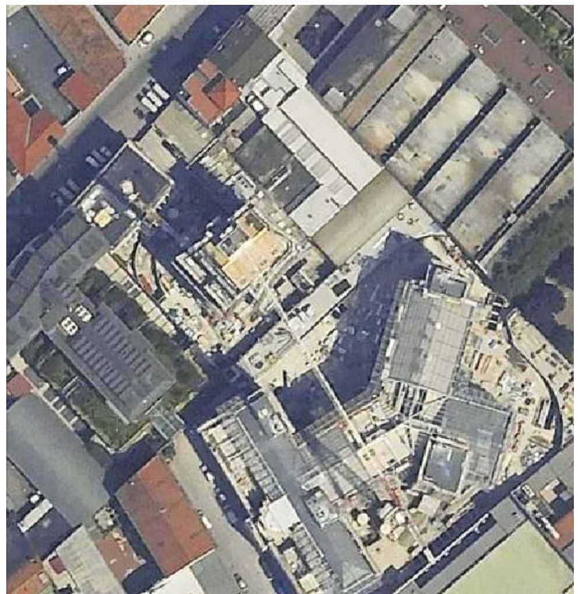
FOTO AEREA DURANTE L'INTERVENTO
