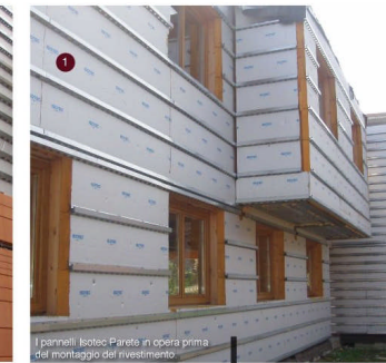
I pannelli Isotec Parete in opera prima del montaggio del rivestimento.
