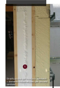
Assemblaggio di tavole in cotto su pannello Isotec Parete.
