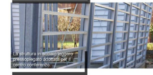
La struttura mista della casa in acciaio e legno lamellare.
