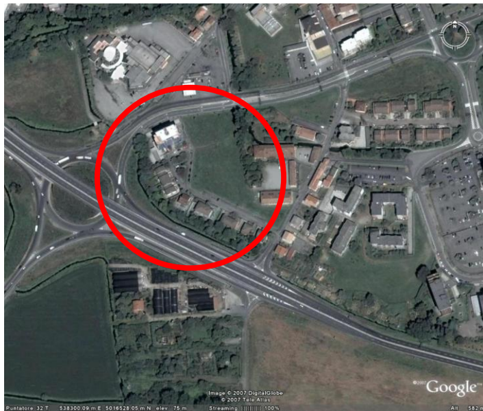
Fotografia aerea dell'area
