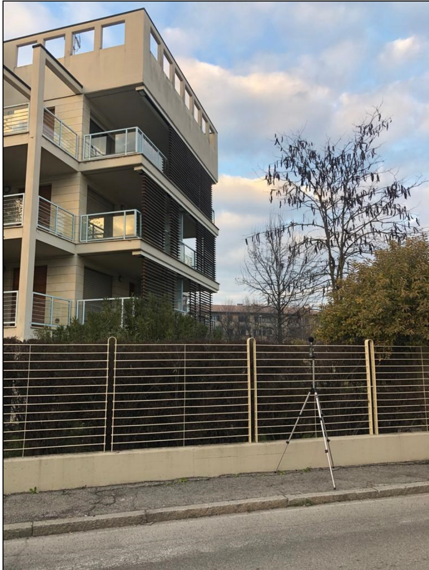
Fotografia punto di misura 1
